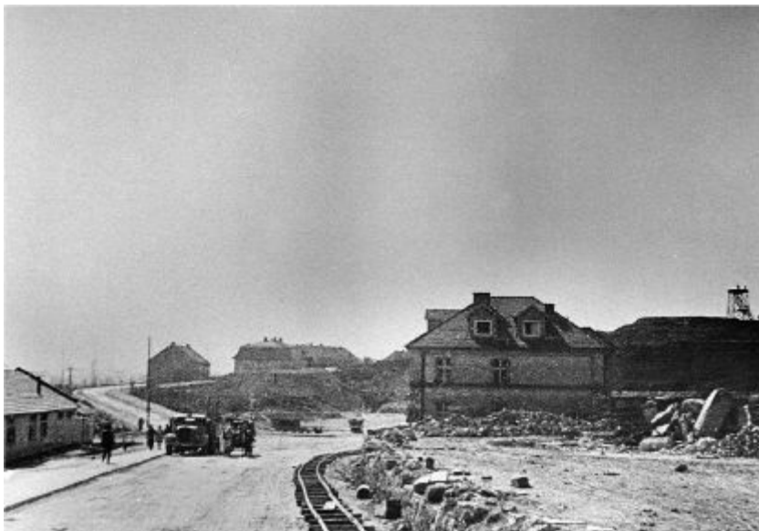
Cracóvia-Plaszów: centro de comando com rua principal do campo. À direita, em primeiro plano, a casa cinza em que fiquei duas semanas na solitária
